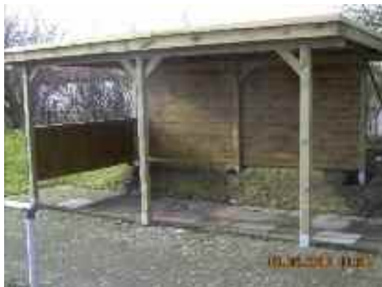
„Drei dieser Unterstände wurden jetzt auf dem Sportplatzgelände aufgestellt“
